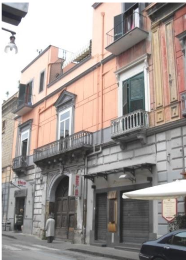
Facciata su corso F. Durante
