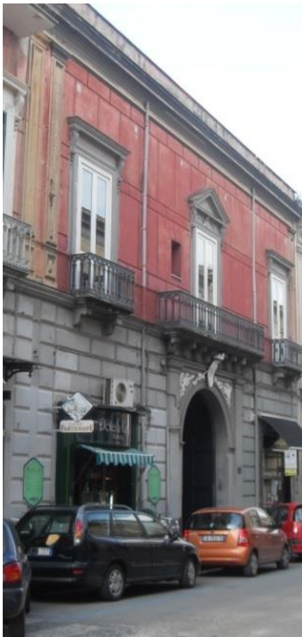
Facciata su corso F. Durante
