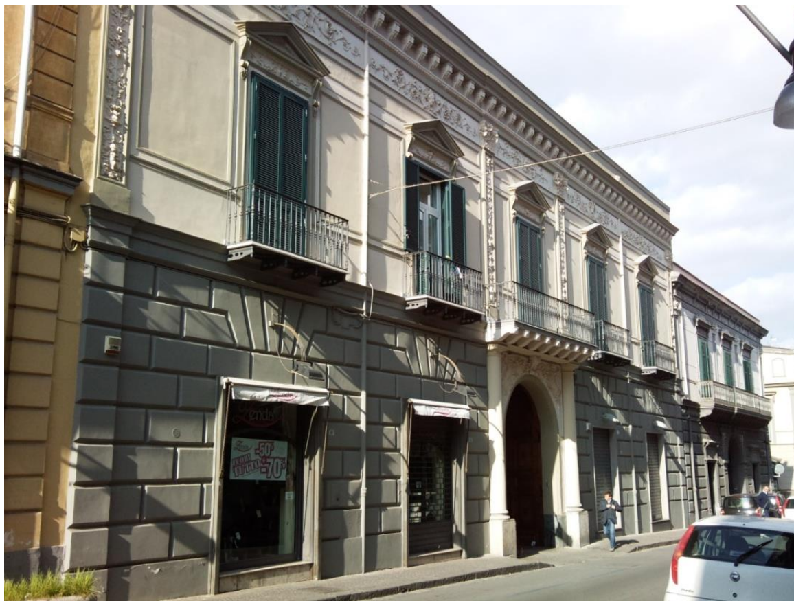
Canapificio Angelo Ferro & Figlio – Facciata
