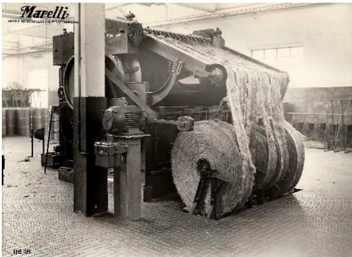
Stabilimento di Frattamaggiore – Carda in grosso con motore MAc 636 10-3-7,5 Cav. della Ercole Marelli Sesto San Giovanni (MI), Istituto per la storia dell'età contemporanea, fondo Archivio Storico Società E. Marelli.
